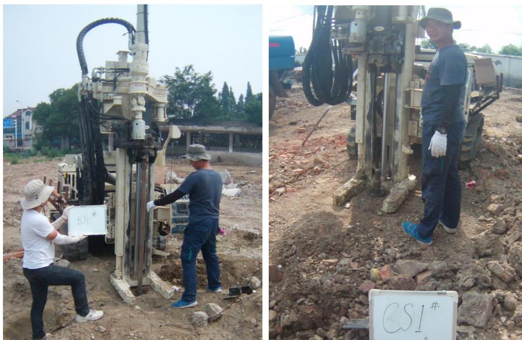
本次调查中所有土孔的钻探和地下水监测井安装，都由专业钻井采样单位在我公司技术人员的旁站下完成。
