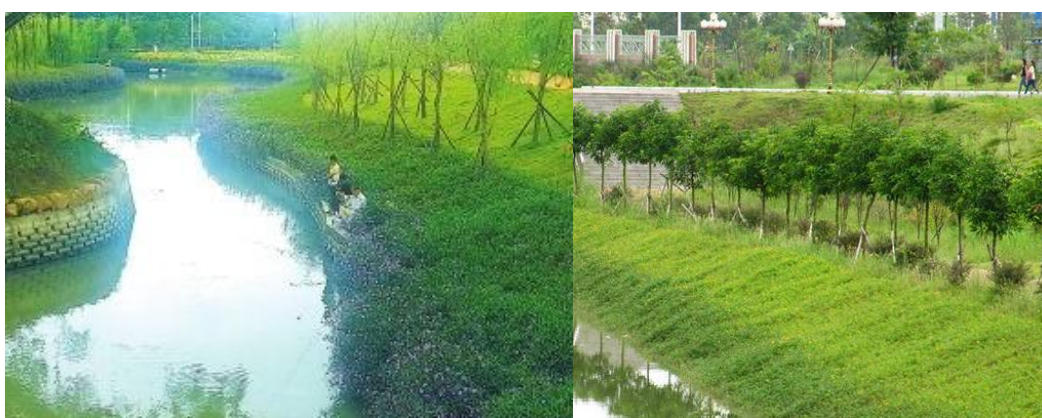
图 C.3 树木-草皮复合防护示例
