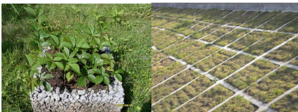
图 C.9 植生混凝土防护示例
