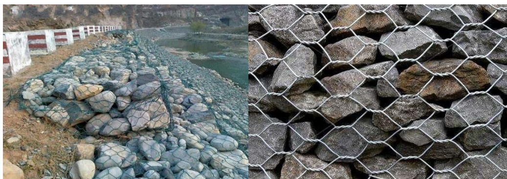
图 C.7 石笼防护示例
