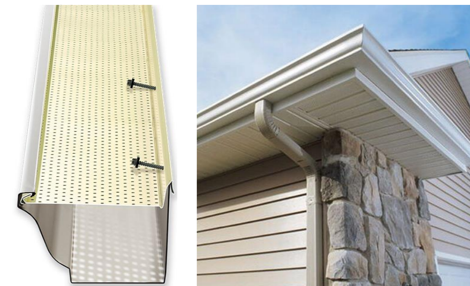
6) 天沟宜结合建筑檐口曲线设计，落水管宜选方管，布置在建筑阴阳角等不显眼处
