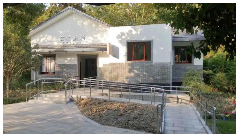
入口设置无障碍坡道
