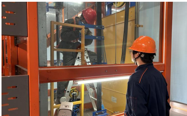
图 2-16 电梯保养与维修项目学生日常实训
