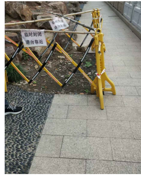
DP2 铺装维修二
