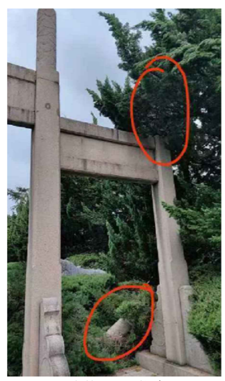
牌坊石柱修复
