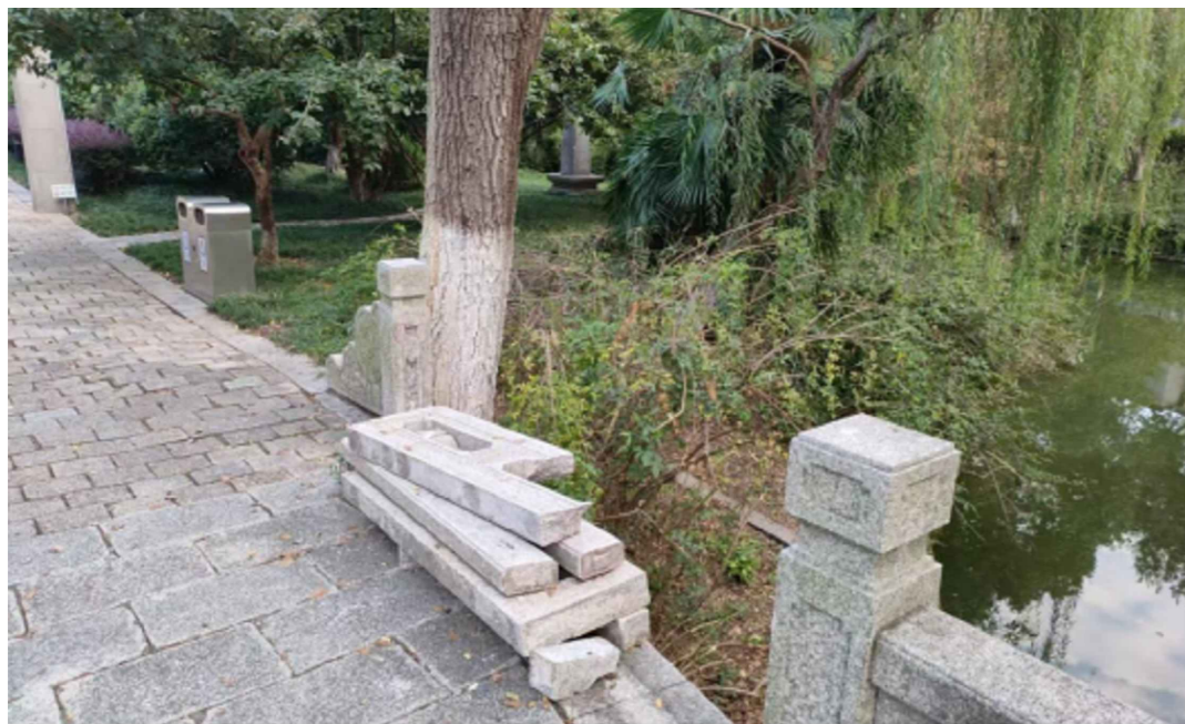
墓道桥石栏杆修复
