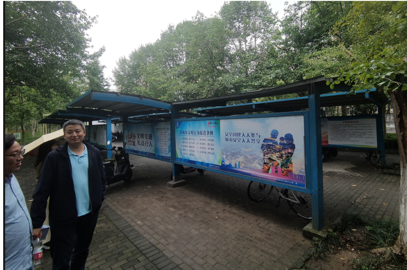
6#岗亭停车场顶棚修复
