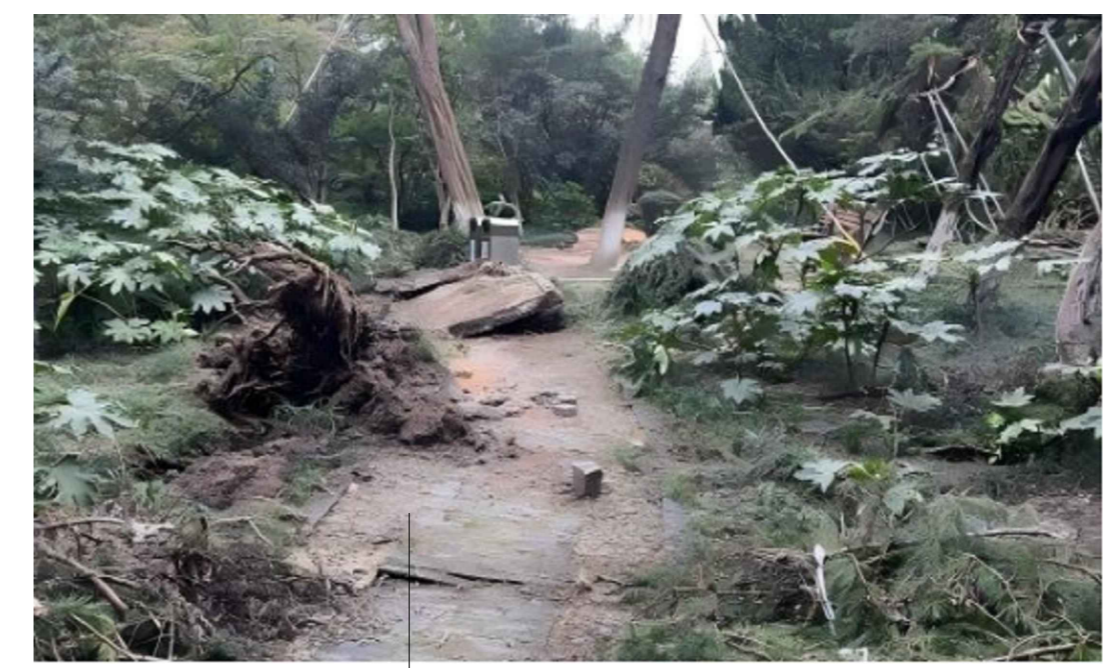
破损路面清理 路基路面修复 墓道一路面损坏
